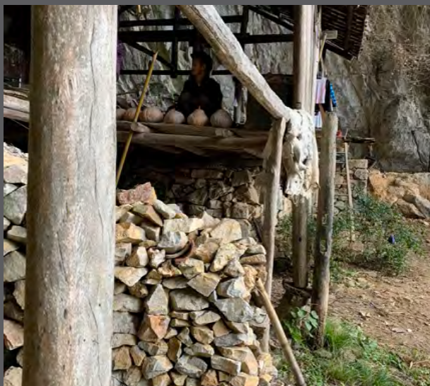
20. Murs sous la maison.
