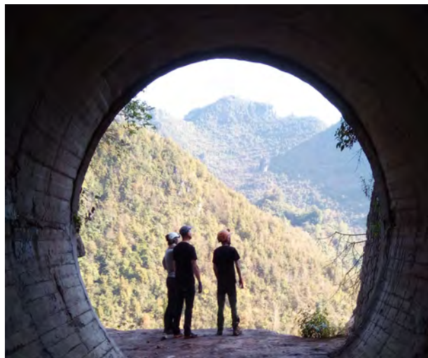
^ Tunnel de décharge de crues
