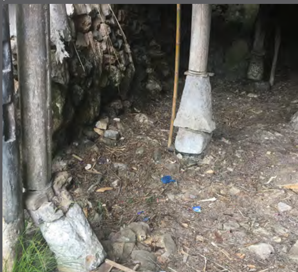
18. Poteaux de la maison et espace sous plancher.
