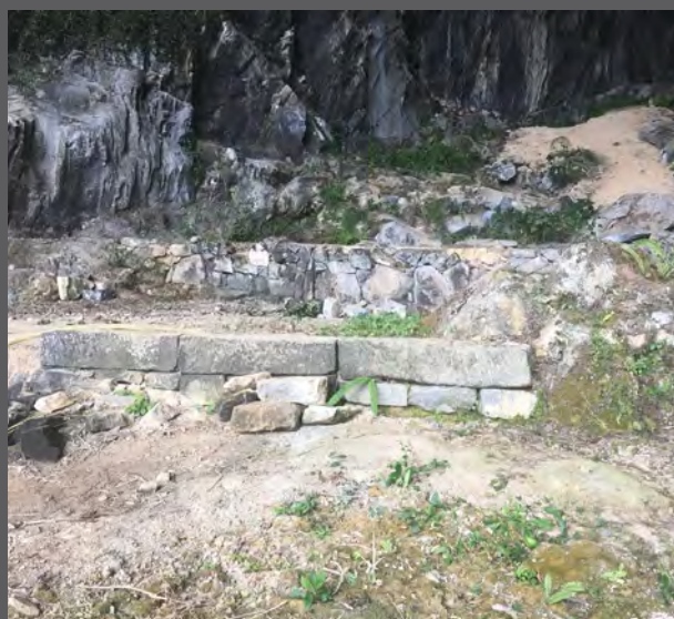
25. Terrasses construites. Notez, en arrière-plan, le tas de terre récemment remuée.
