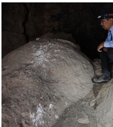
Fig.27 : tine et chenal liés à la biocorrosion par du guano de chauve-souris. Photo LBQ
