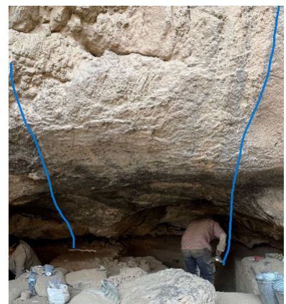
Fig.9 : la voûte au fond du porche est marquée par des écoulements d'eau pouvant être à l'origine du chenal visible dans les sédiments. Photo LBQ
