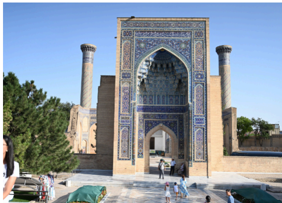
Les coupoles sont habillées de muqarnas qui évoquent des stalactites de la grotte dans laquelle se réfugia le prophète Mahomet lors de sa fuite de la Mecque. Photo VOL
